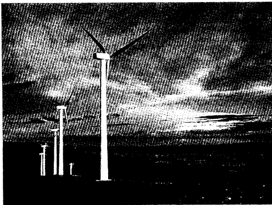
Eólicas de Euskadi gestiona cuatro parques en la comunidad autónoma. En la foto, las instalaciones de Elgea.
